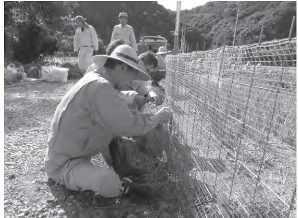
図 - 7 小代用心棒設置作業
