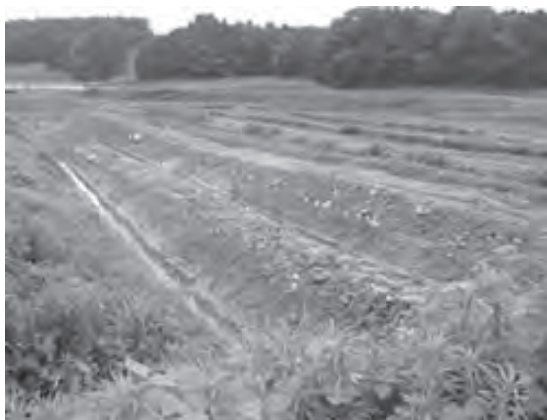
図2 暗渠用仮排水路素堀
