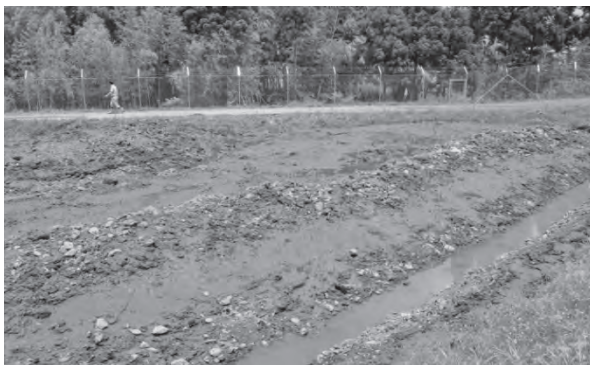
図6 仮排水路の設置
