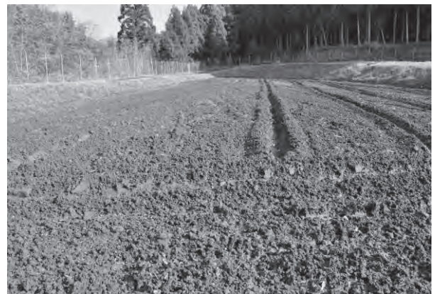
図8 暗渠工事後埋め戻し
