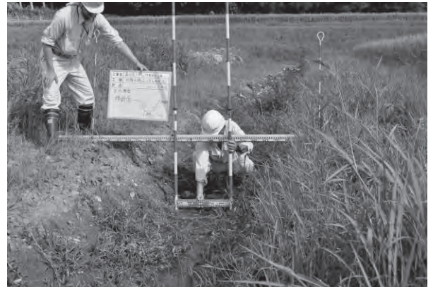
図7 排水路落成検査
