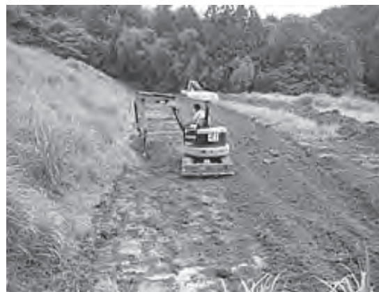
図4 暗渠排水の埋め戻し
