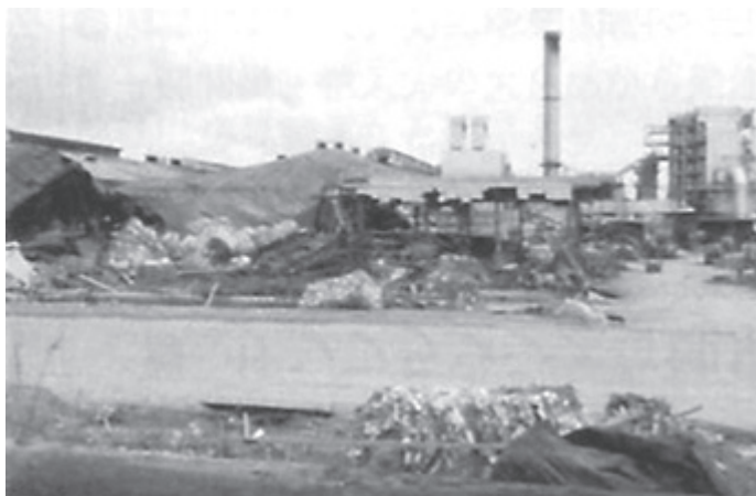
写真4 津波で壊滅的被害を受けた工場(石巻市)
