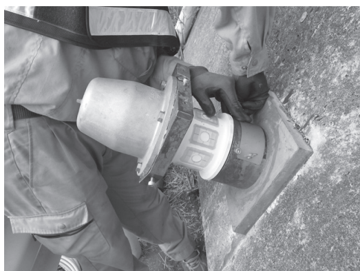
図-8 Mリングの設置状況
