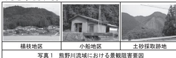
写真 1 熊野川流域における景観阻害要因
